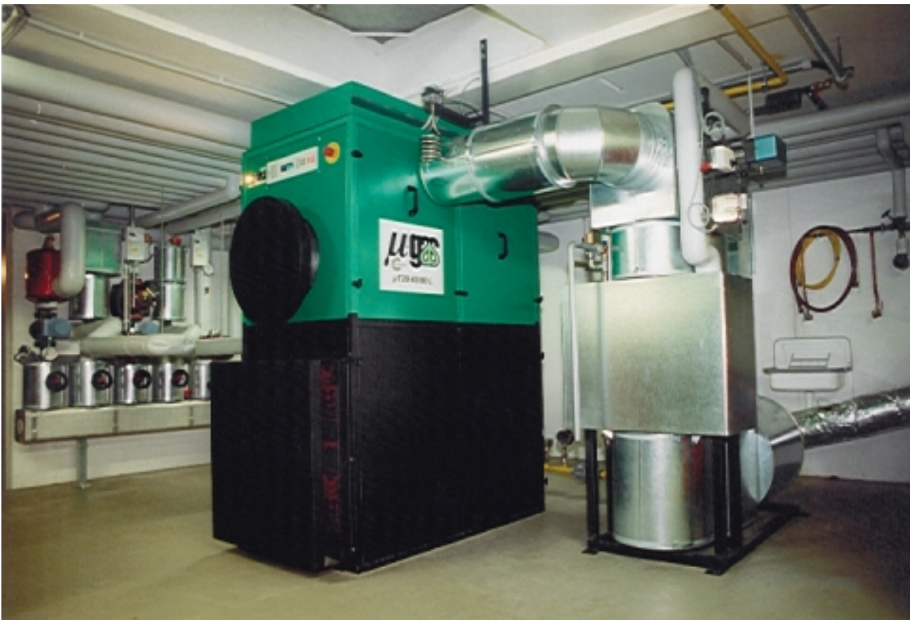
Bild 11: Mikrogasturbinen-KWK-Anlage
